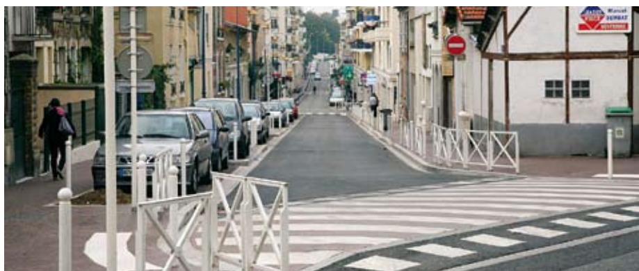
Voirie refaite entre République et Verdun.
