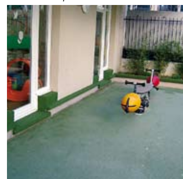
Protections espace multi-accueil.
