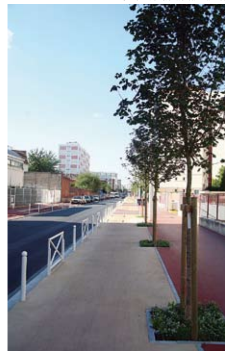
Voirie Avenue de la Marne.
